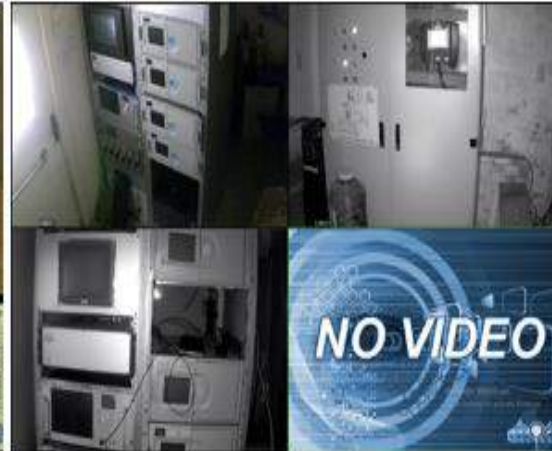
Theo dõi hoạt động, công tác duy trì các trạm qua hệ thống Camera
